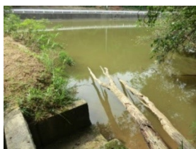
土砂や流木等の撤去
