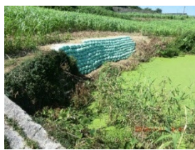
土のうによる崩落箇所の拡大防止
