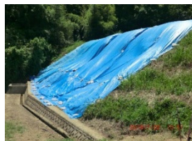
ブルーシートによる被災箇所保護
