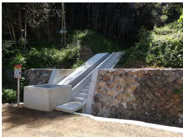
写真-4.5.5 擁壁、承水路の設置事例
