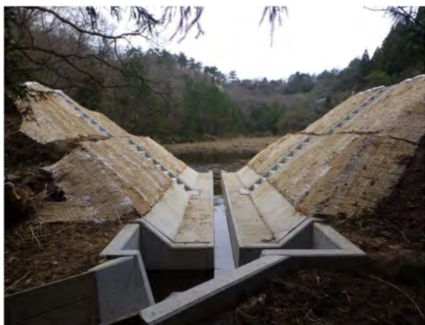
写真-4.5.3 接続桝の設置事例
