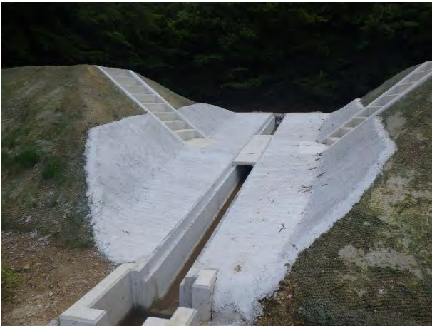
写真-4. 5. 6 階段工の設置事例
