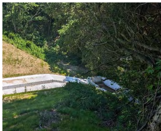
写真-4.5.4 急流工の設置事例
