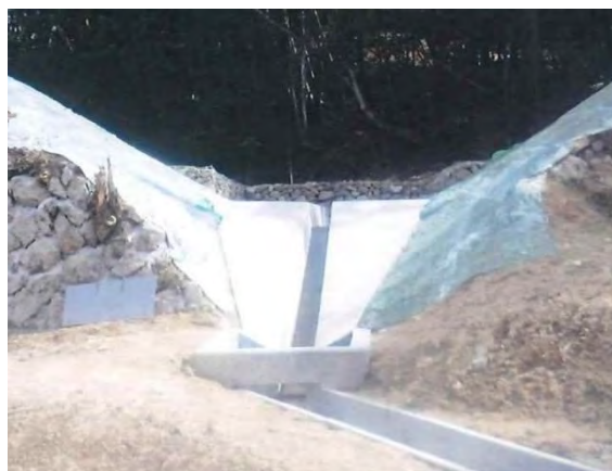
写真-4.5.4 急流工の設置事例
