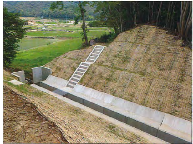
写真-4. 5. 6 階段工の設置事例
