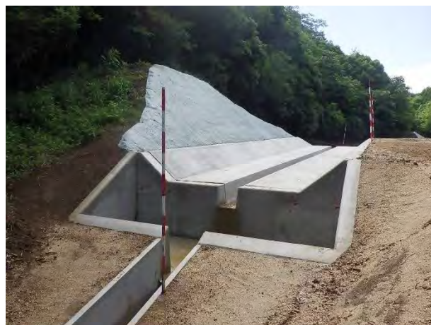
写真-4.5.3 接続桝の設置事例
