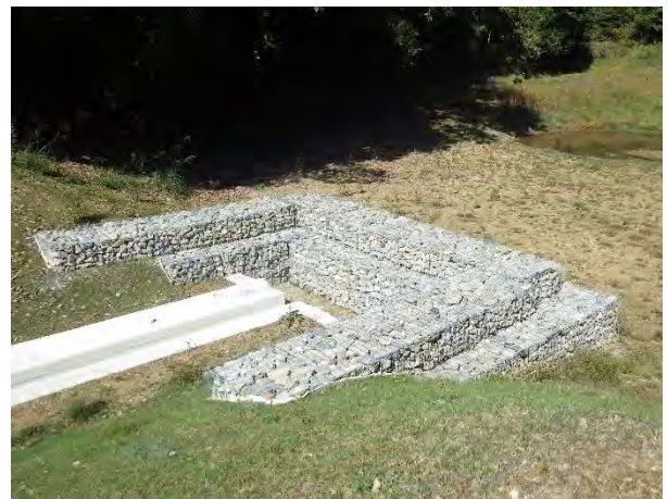
写真-4.5.1 ふとんかご等による土砂留設置事例
