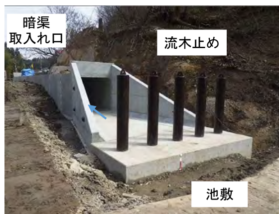
写真-5.3.1 暗渠上流側の流木止め設置例
