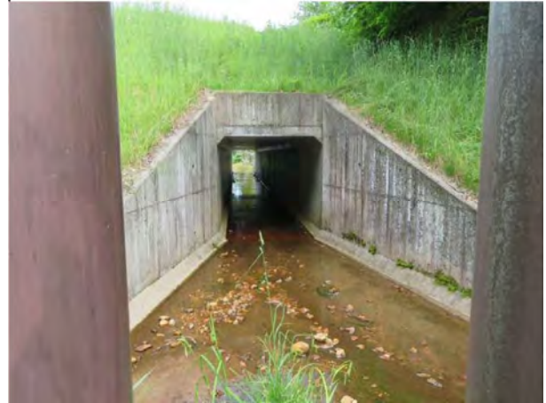
写真-3.4 暗渠工法によるため池の廃止事例2
