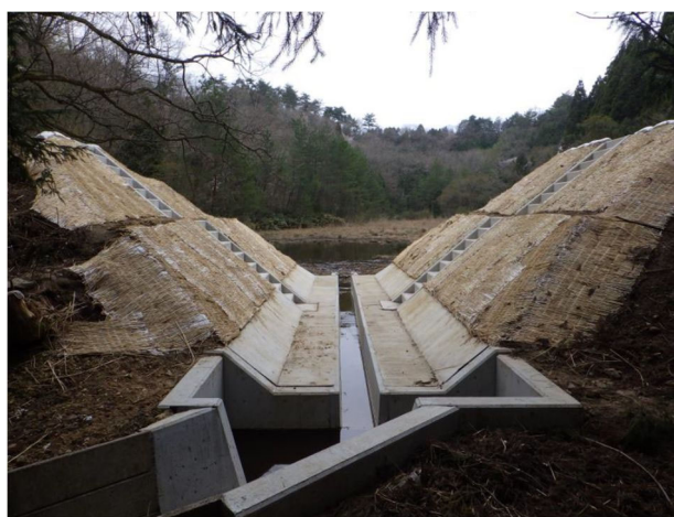
写真-4.5.3 接続桝の設置事例
