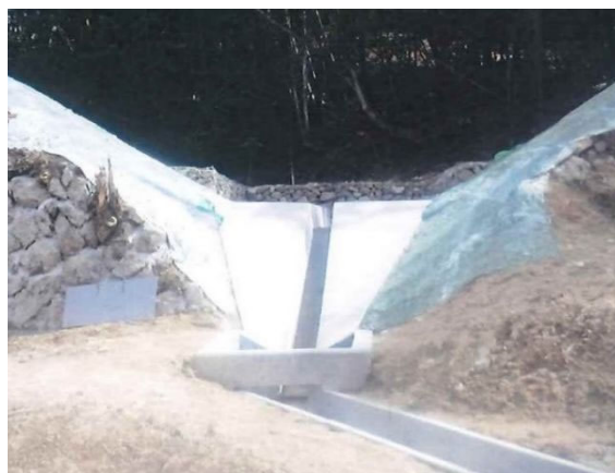
写真-4.5.4 急流工の設置事例
