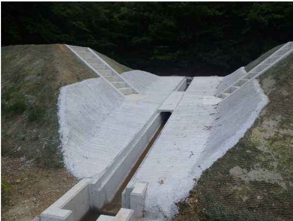
写真-4. 5. 6 階段工の設置事例
