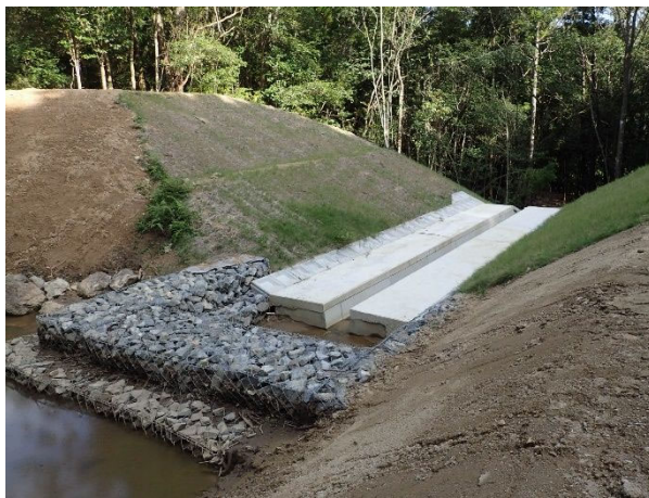
写真-4.5.1 ふとんかご等による土砂留設置事例
