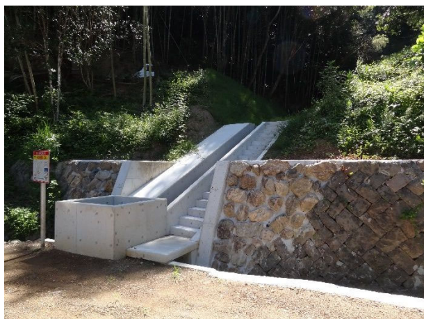
写真-4.5.5 擁壁、承水路の設置事例
