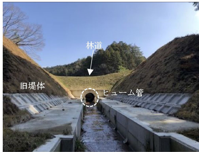
写真-3.8 堤体開削工法と暗渠工法の複合工法の事例 1)
