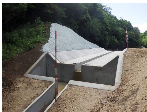
写真-4.5.3 接続桝の設置事例
