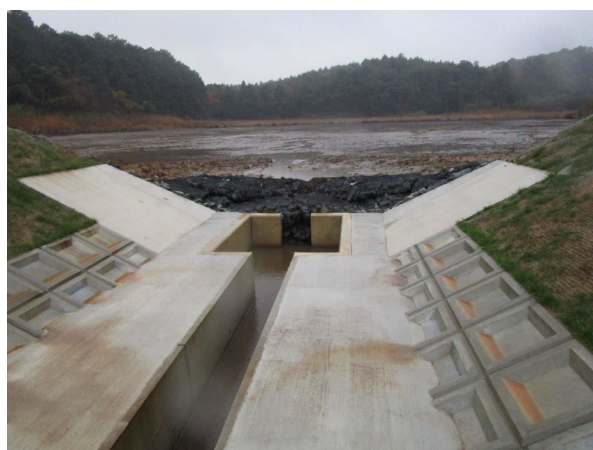
写真-4.5.2 集水樹の設置事例
