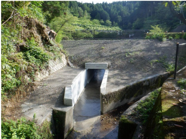
写真-3.3 暗渠工法によるため池の廃止事例1
