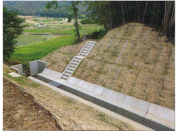
写真-4. 5. 6 階段工の設置事例
