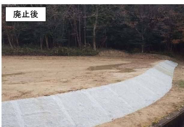
写真-3.7 堤体開削工法と埋立工法の複合工法の事例
