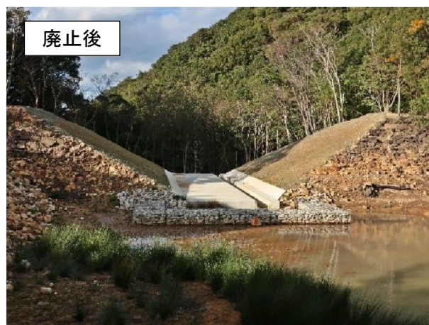
写真-1.1.1 堤体開削工法によるため池の廃止事例
