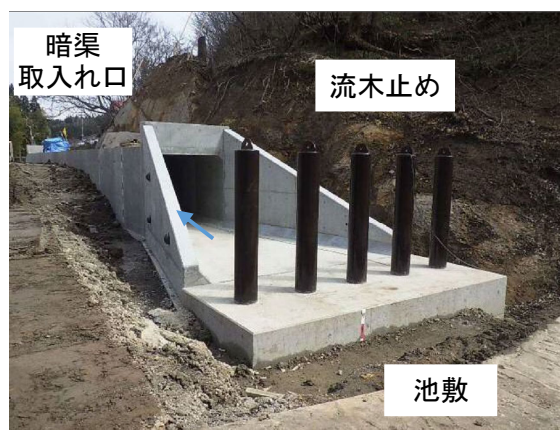
写真-5.3.1 暗渠上流側の流木止め設置例
