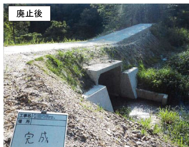
写真-1.1.2 暗渠工法によるため池の廃止事例
