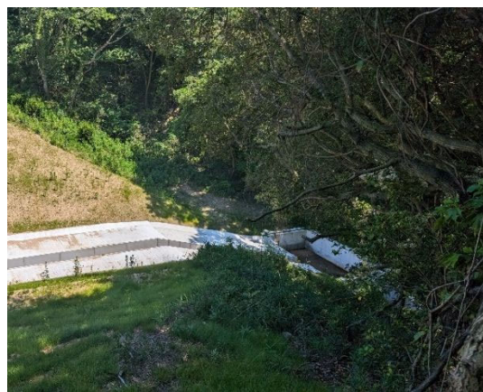
写真-4.5.4 急流工の設置事例
