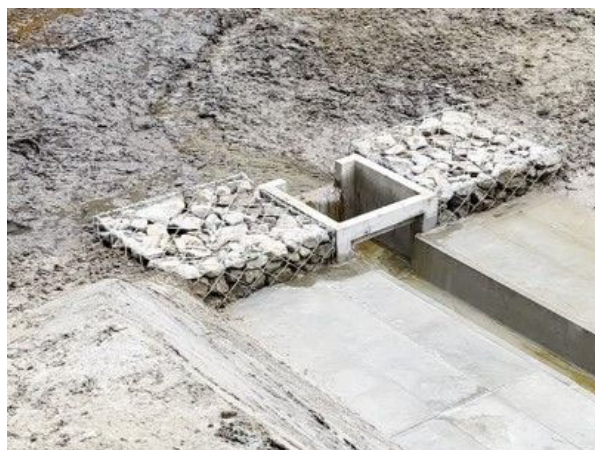
写真-4.5.2 集水樹の設置事例
