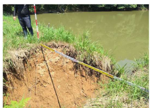
被災により崩落した堤体の点検調査を実施。
