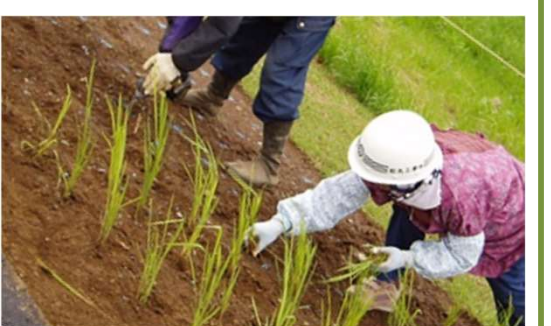
改修後に堤体法面へ植付け
