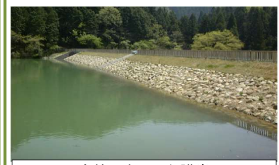
自然石を用いた護岸
