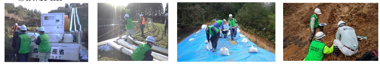
ため池における排水ポンプによる応急対策 侵食防止対策(ブルーシート張り) 復旧工法の検討
