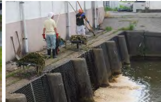
スクリーンの除塵作業
