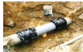
漏水防止のための整備
