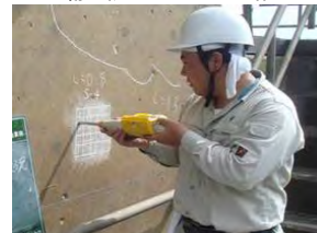
老朽化した施設の機能診断
