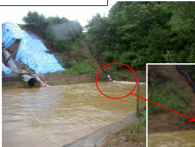
仮排水路設置状況
