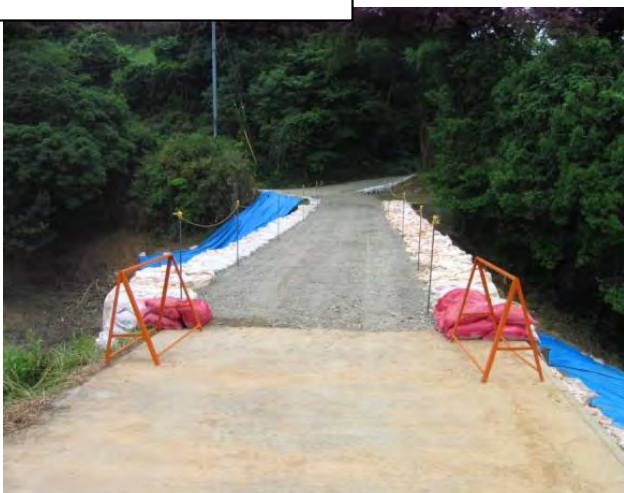
堤体仮補修状況
