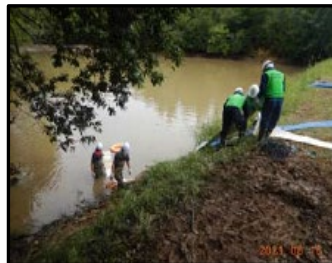
【排水ポンプによる技術支援】
