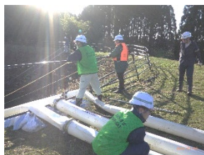
ため池における排水ポンプの設置
