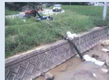
仮設ポンプを設置し、用水を確保
