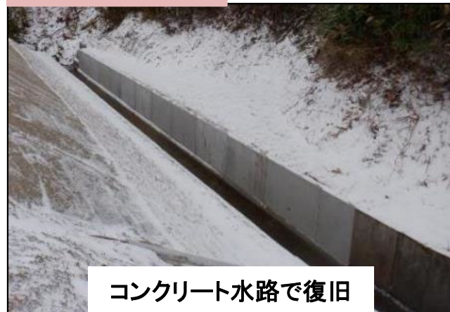
改修内容(水路)
