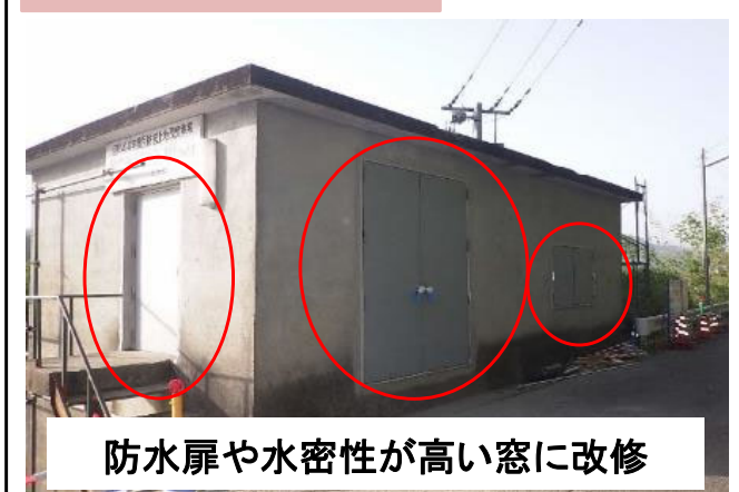
改修内容(揚水機場)
