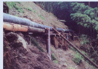
仮設水路を設置し、用水を確保
