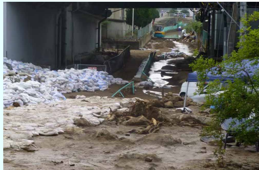
水路の埋塞(8月 広島県広島市)
