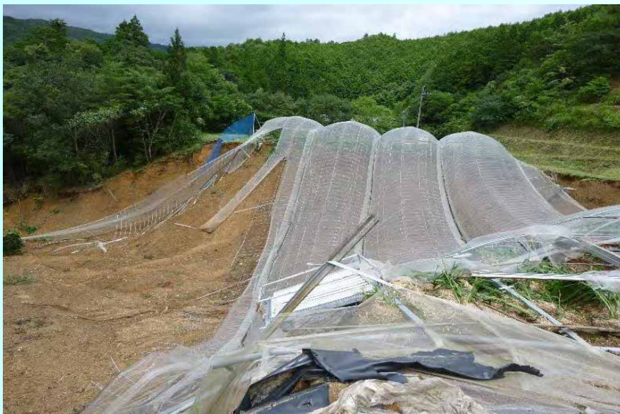
畑地の法面崩壊(8月 高知県四万十町)
