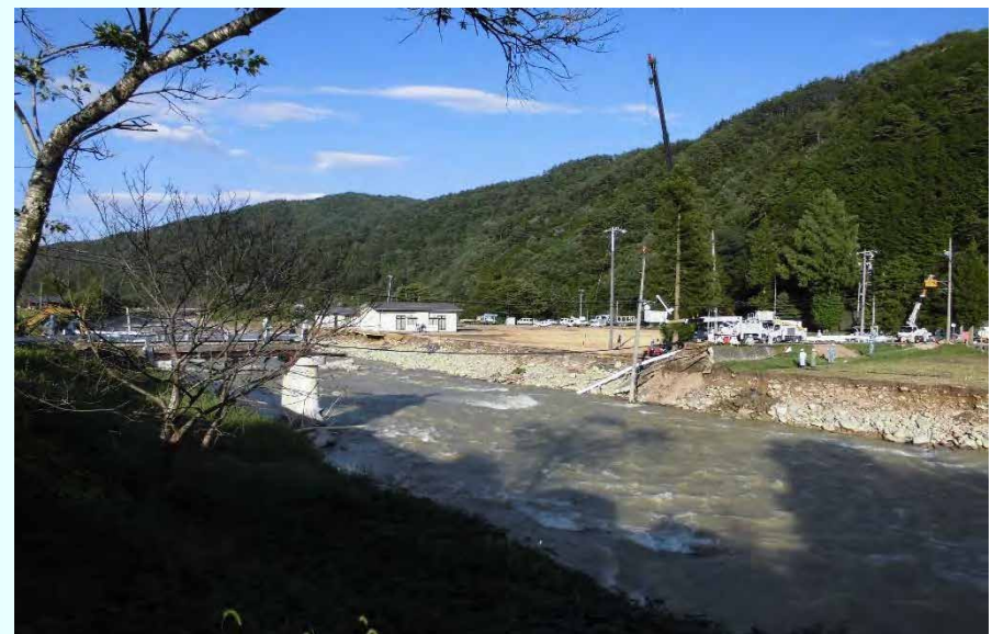
橋梁に添架している集排水管の被災(8月 岐阜県高山市)
