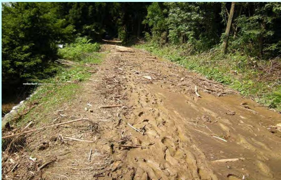
用水路の埋塞(7月 富山県魚津市)
