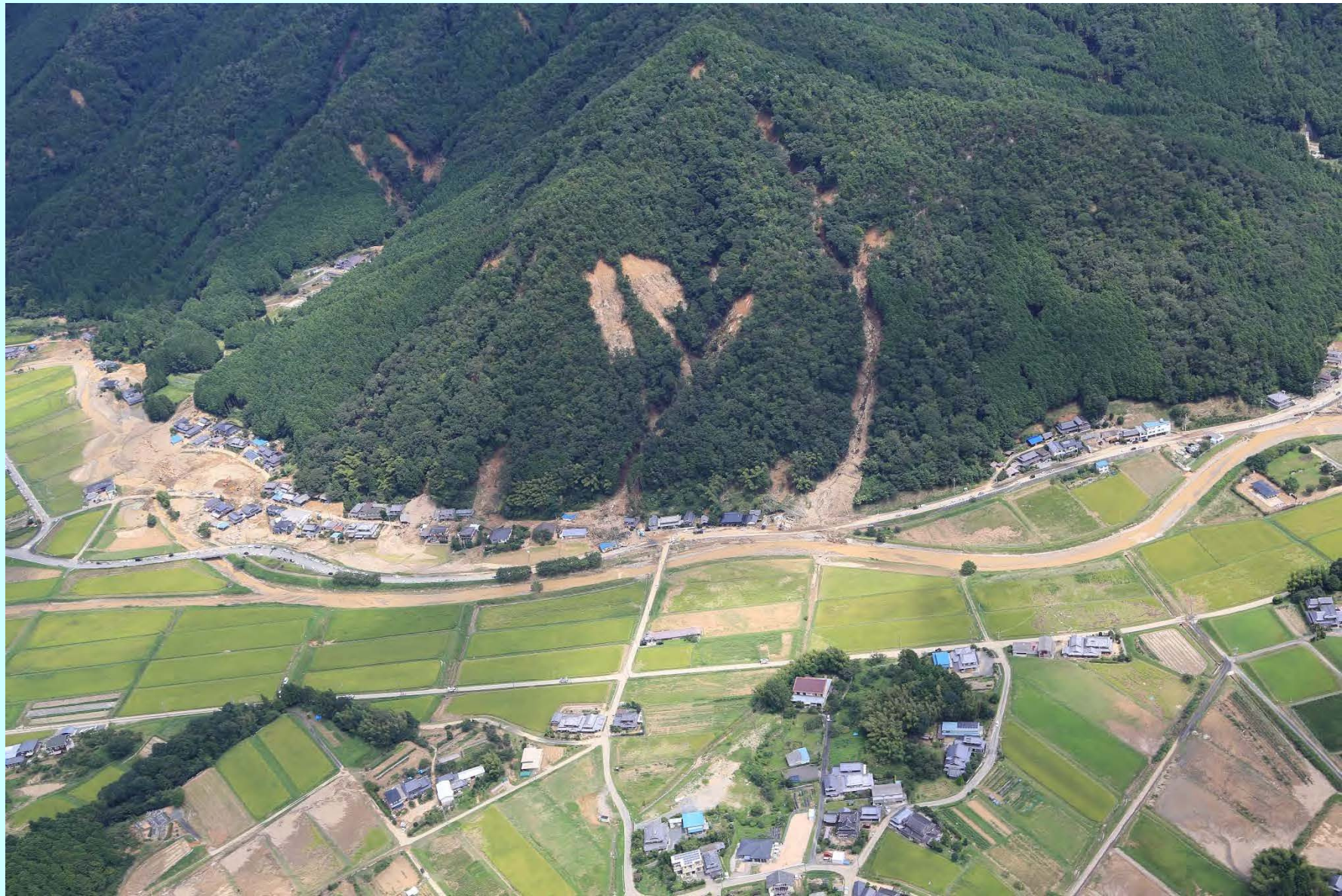
河川の氾濫、山腹崩壊による農地、農業用施設の被災(8月 兵庫県丹波市)
