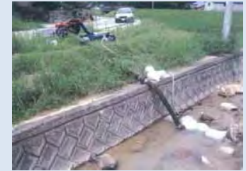
仮設ポンプを設置し、用水を確保
