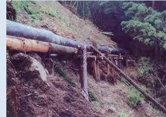
仮設水路を設置し、用水を確保
