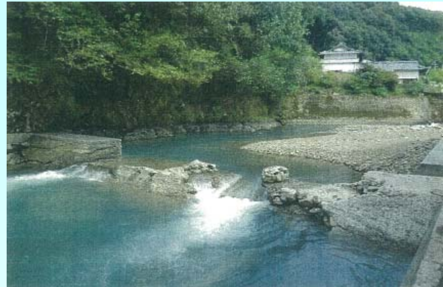
頭首工の被災(9月 台風16号 宮崎県門川市)
