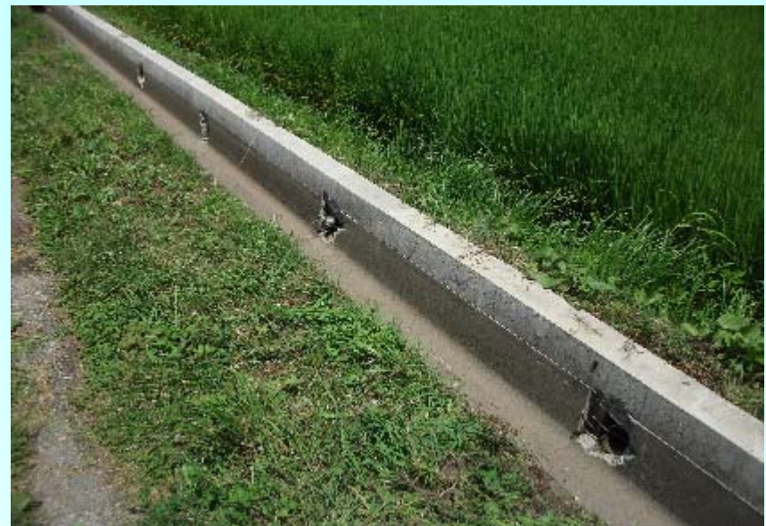
用水路継目部欠損(8月 落雷 千葉県木更津市)
