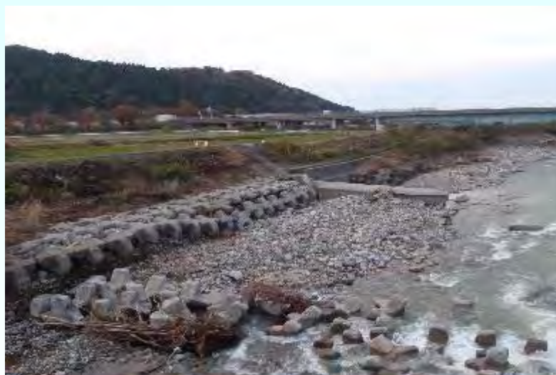
頭首工の被災(10月 台風21号 新潟県糸魚川市)
