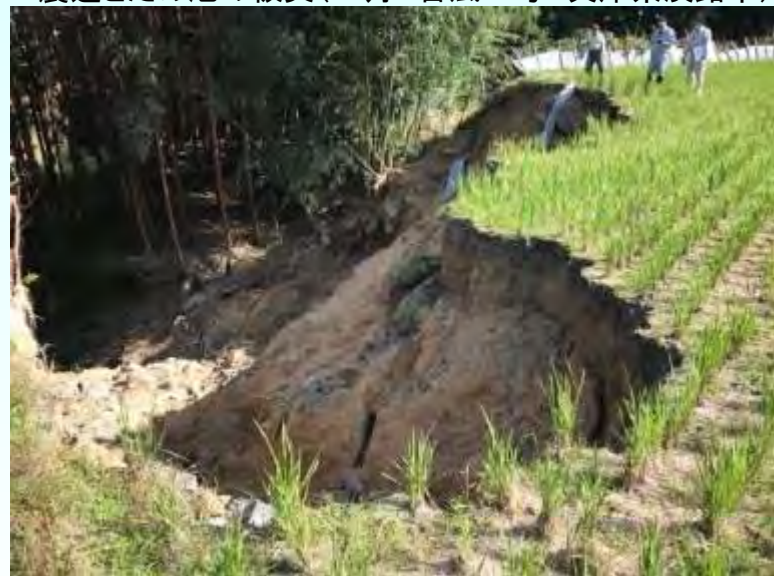
農地の被災(10月 台風21号 大阪府河南町)
