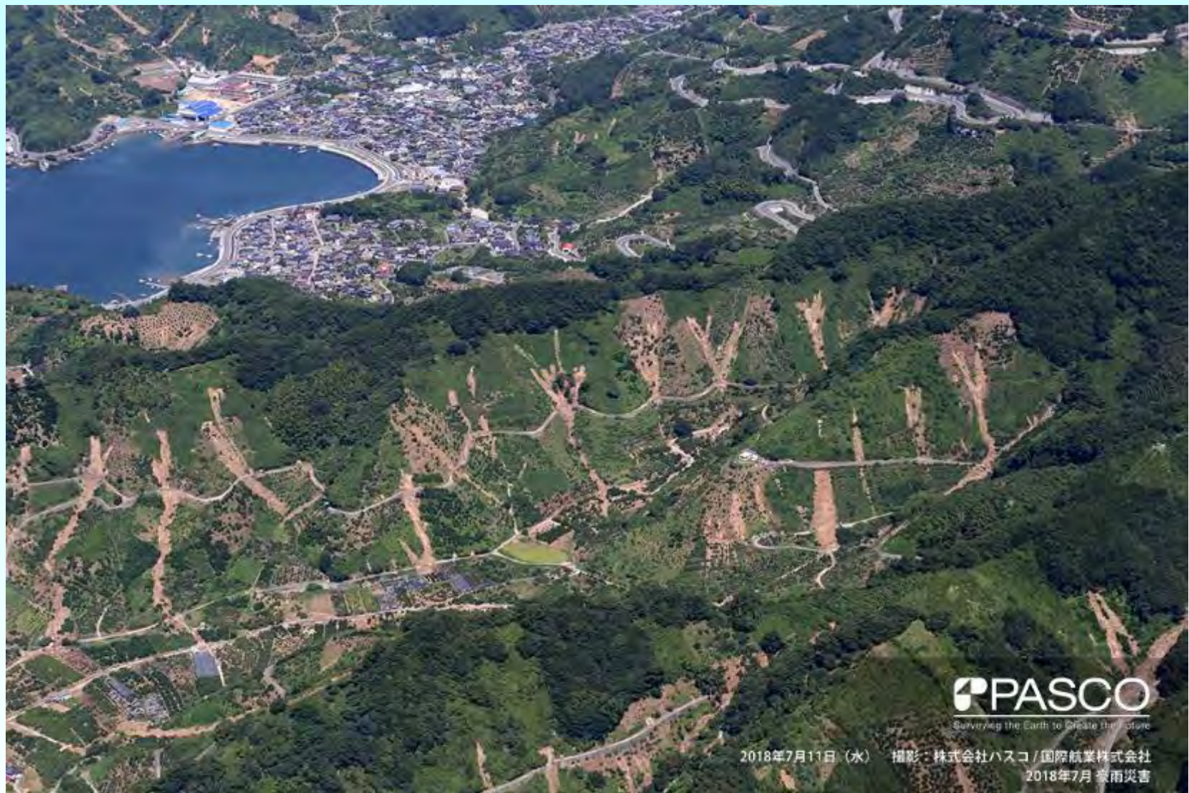
農地と農道と水路の被災（7月 梅雨前線 愛媛県宇和島市）
