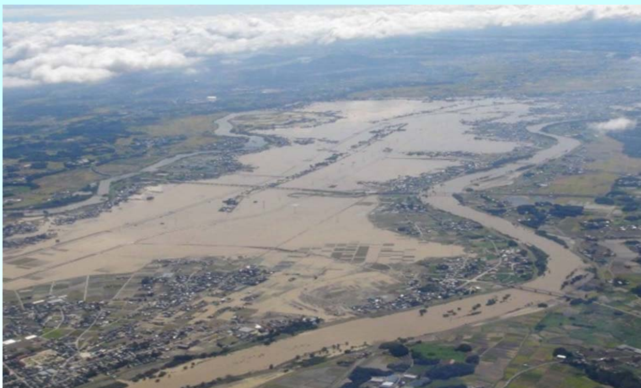
堤防決壊により広範囲で農地、農業用施設の被災(9月 茨城県常総市)
