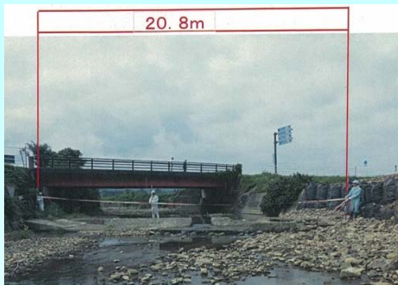
頭首工の被災(6月 熊本県苓北町)
