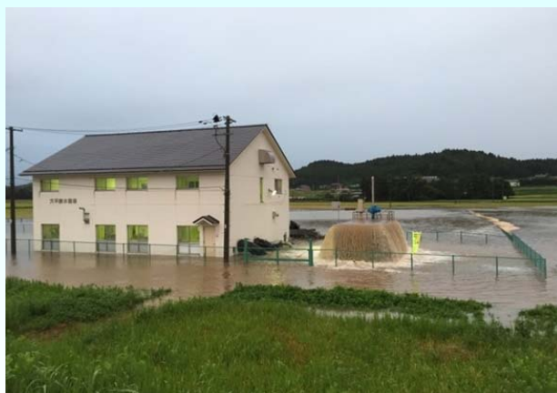
排水機場の被災(9月 宮城県大和町)
