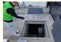
農業集落排水施設の点検
