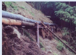
仮設水路を設置し、用水を確保
