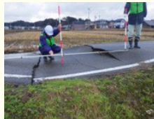
農業用パイプラインの被災状況調査
