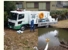
排水用ポンプ車の派遣
