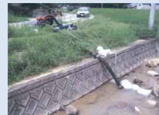
仮設ポンプを設置し、用水を確保
