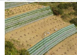
傾斜の途中に土留工(かご枠)を設置し、緩傾斜地化
