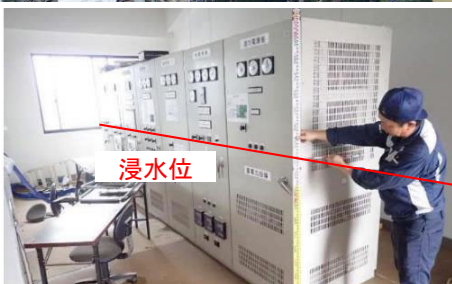
被災した電気設備（操作盤）
