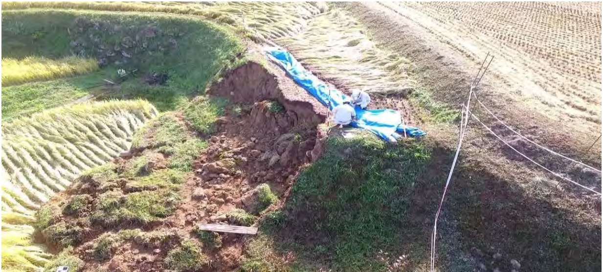
ドローンによる撮影(被災地側面 西側より撮影)
