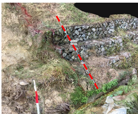
図3-61 三次元データからふとんかごの断面を取得した例
