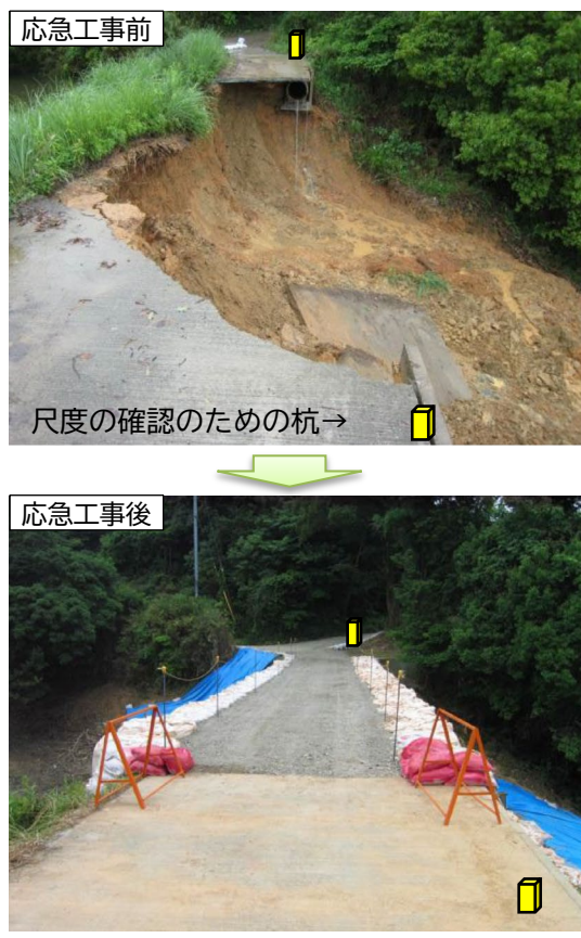
図3-57 応急工事着手前の三次元データ取得イメージ
