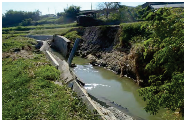
水路(土砂崩壊の三次元化は可能だが、水路の規格や中心位置の特定は困難)
