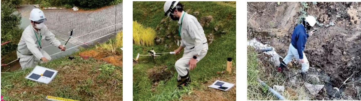
図 3-30 足場の悪い場所での撮影風景
