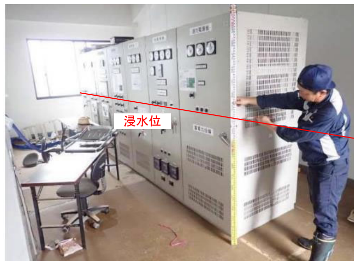
被災した電気設備（操作盤）
