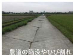
農道の陥没やひび割れ
