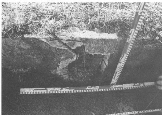
写真 2-10-3 用水路の破損状況
