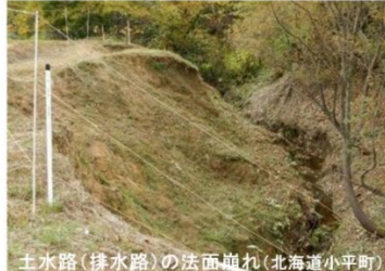
土水路(排水路)の法面崩れ(北海道小平町)
