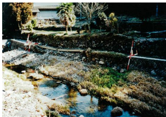
(河川氾濫により水路並びに護岸流出)
