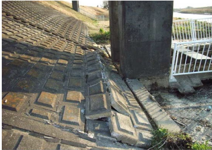
写真 2-8-8 張ブロック護岸の被災（東北地方太平洋沖地震(H23.3)）
