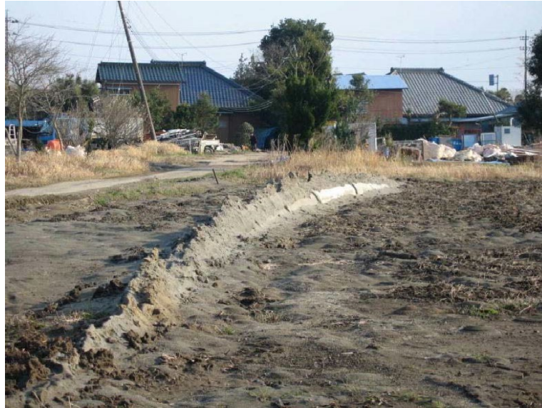
写真 2-8-6 管の浮上被害(東北地方太平洋沖地震(H23. 3))
