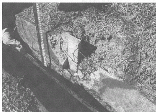
写真 2-10-3 用水路の破損状況
