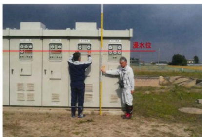
被災した電気設備（操作盤）
