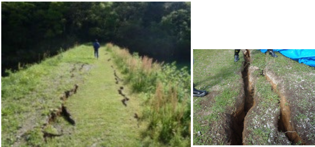
写真 2-8-4 堤体のき裂被害（熊本地震(H28.4)）
