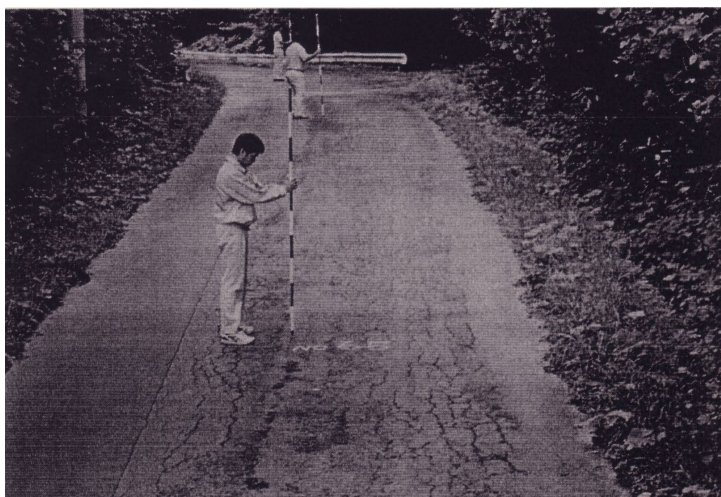
写真 2-11-1 凍上による被災状況
