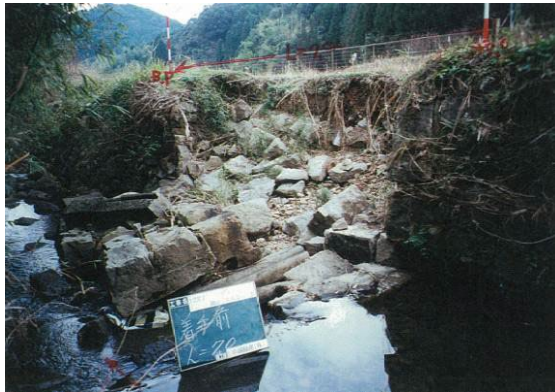
(集中豪雨により頭首工の護岸が崩壊)
