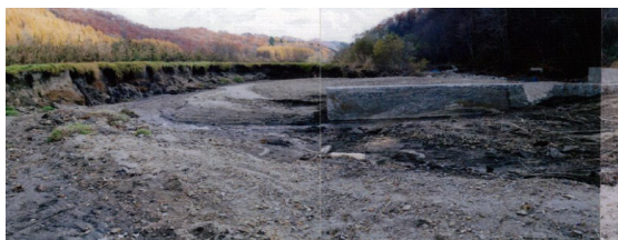
(豪雨による異常出水により石積擁壁が崩壊)
