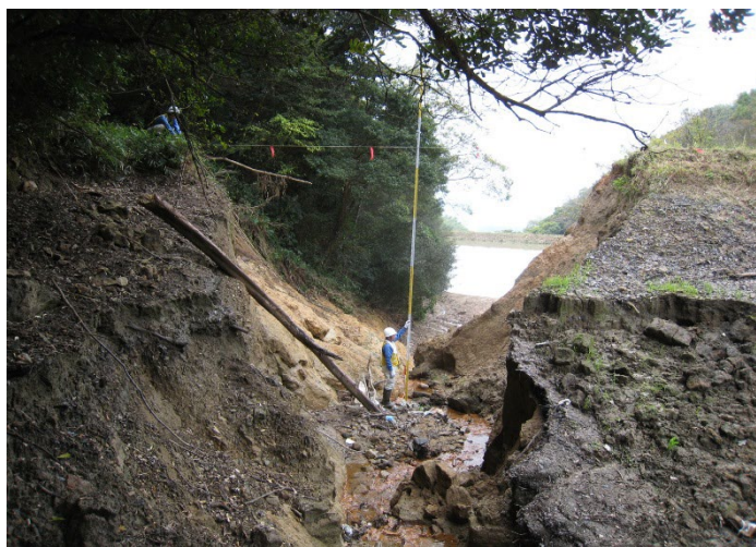
写真 4-2-7 豪雨によるため池余水吐被災事例
