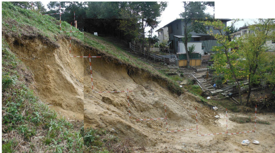
写真 4-2-4 豪雨によるため池後法面滑落被災事例
