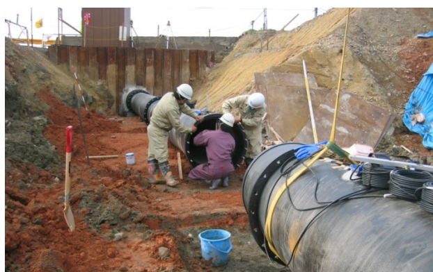
写真 4-5-1 柔構造底樋の施工状況
