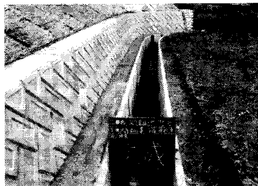
b. ブロック積+コンクリート二次製品水路
