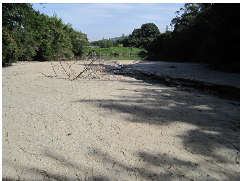
写真 4-2-2 ため池埋そく被災事例(2)
