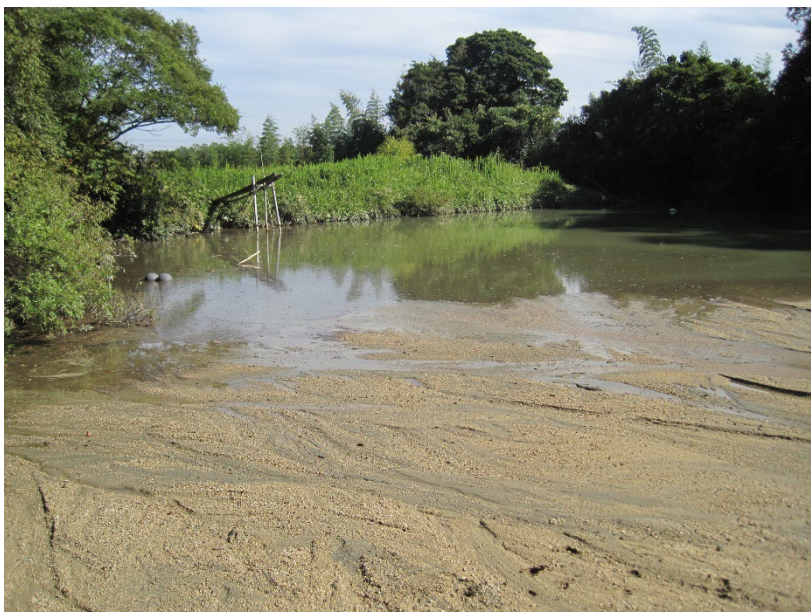
写真 4-2-1 ため池埋そく被災事例(1)
