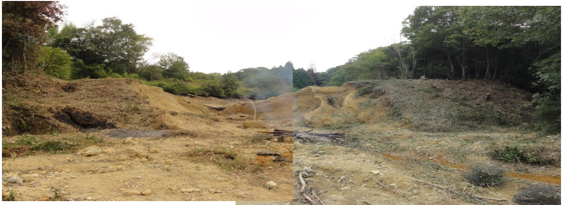
写真 4-2-6 豪雨によるため池決壊被災事例
