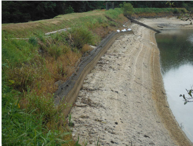
写真 4-2-3(2) 側面写真（上流法面保護基礎が押されている）
