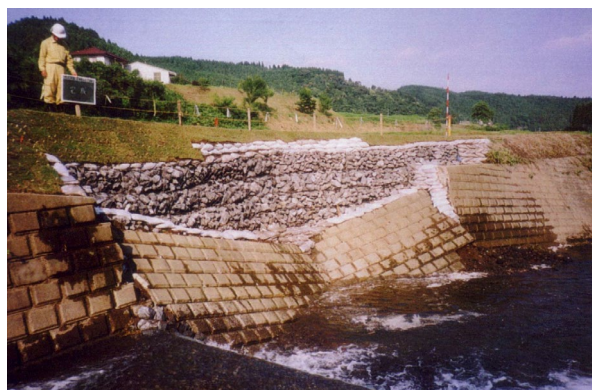
写真 12-2-5 頭首工の応急仮工事
