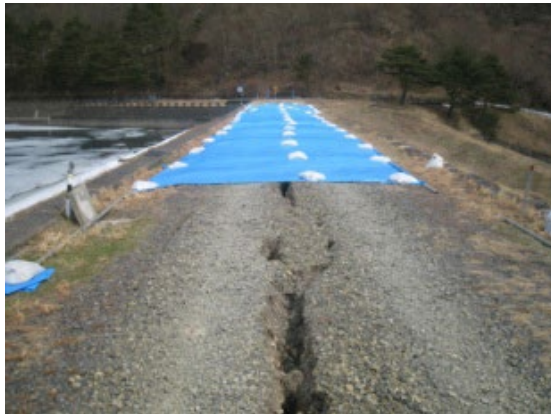
写真 12-2-1 ため池の地震直後の被災写真
