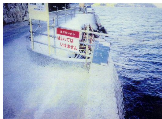
写真 12-2-6 海岸堤防の応急仮工事
