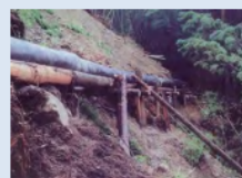
仮設水路を設置し、用水を確保
