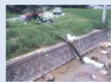
仮設ポンプを設置し、用水を確保
