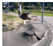
地震により被災した集落排水施設
