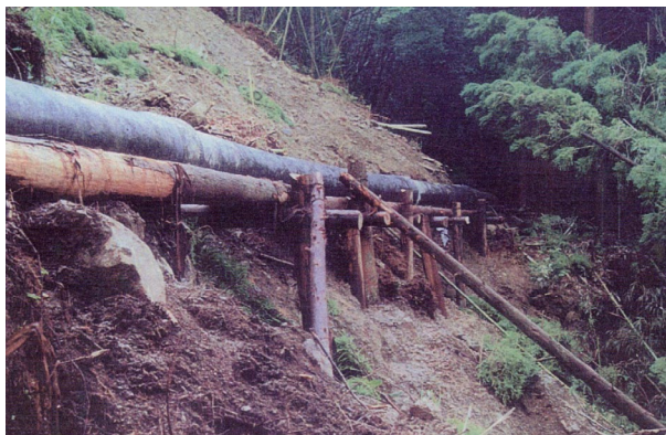
写真 12-2-3 用水路の応急仮工事
