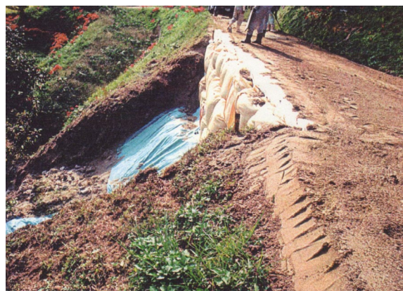
写真 12-2-4 農道の応急仮工事
