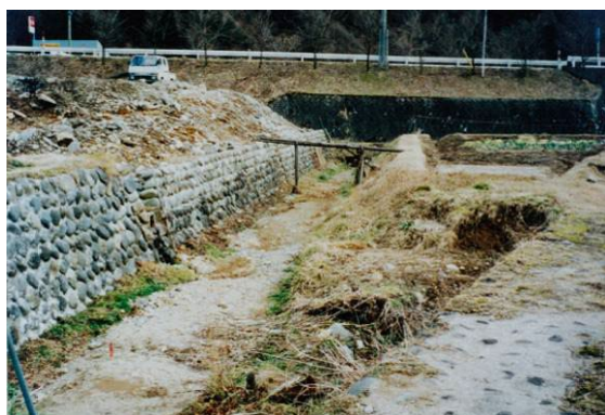
(河川氾濫により用水路に土砂が堆積)
