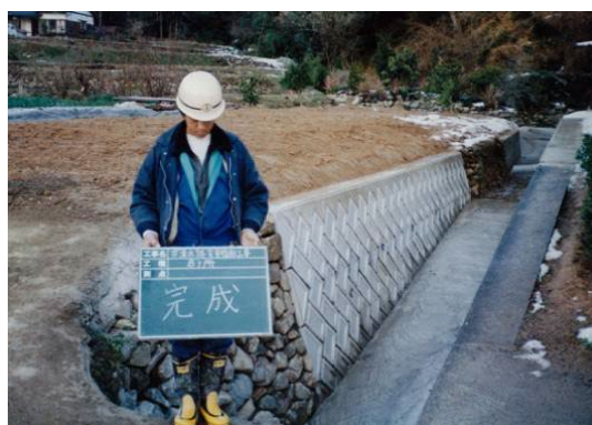
(ブロック積+底張で復旧)
