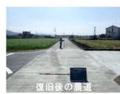
復旧後の農道
