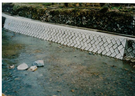
(ブロック積と水路復旧)
