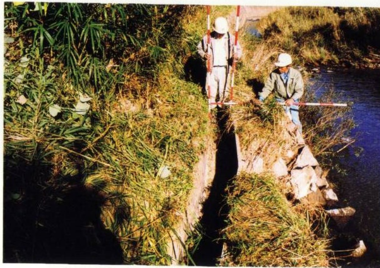
写真 2-12-5 水路の断面写真
