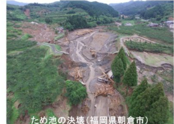
ため池の決壊(福岡県朝倉市)
