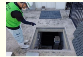
農業集落排水施設の点検
