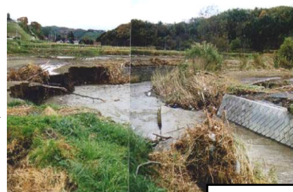
木橋をPC橋で復旧
