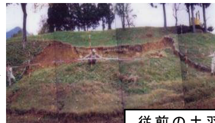
従前の土羽による畦畔の復旧
