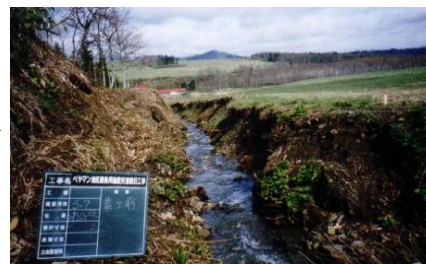
土水路をU字フリュームで復旧
