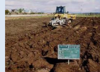
農道や農地に堆積した土砂等の撤去
