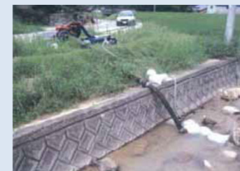
仮設ポンプを設置し、用水を確保
