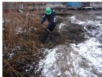
水路内堆積土砂撤去
