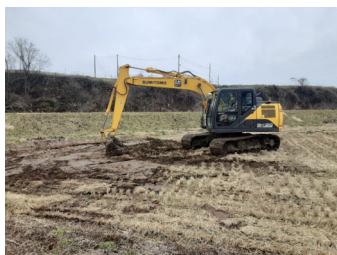
堆積土砂撤去
