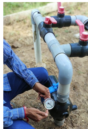
点滴灌漑設備の設置
