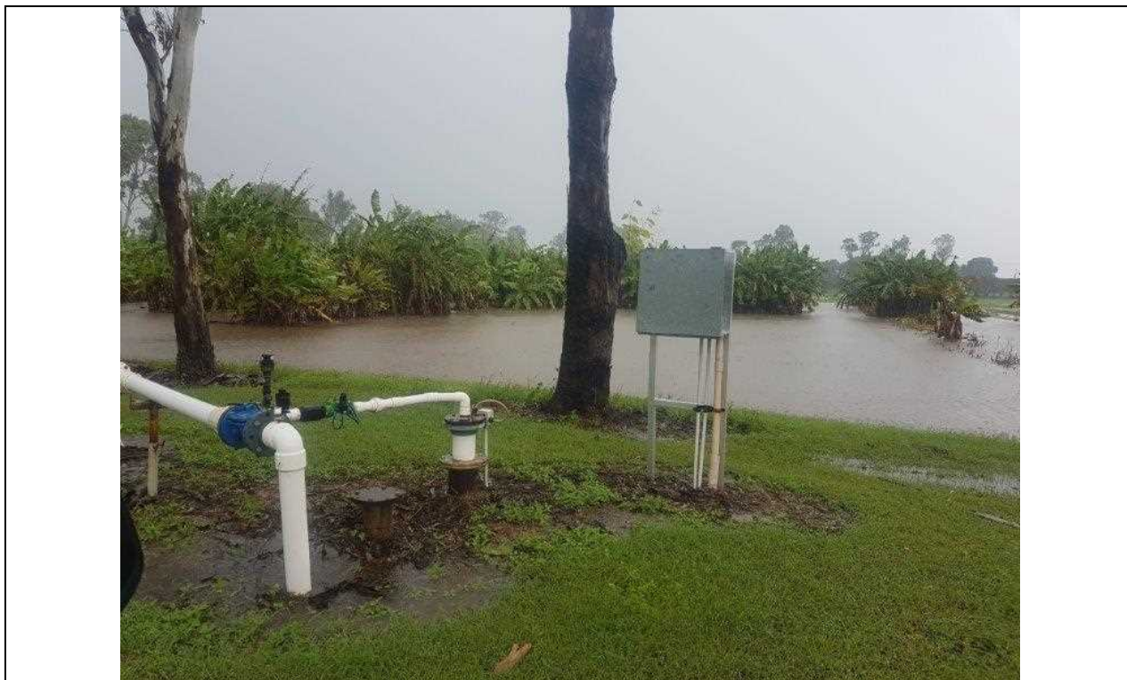
図表 27 集中豪雨後のシェードハウス周辺の状況(試験栽培バナナの木が灌水)
