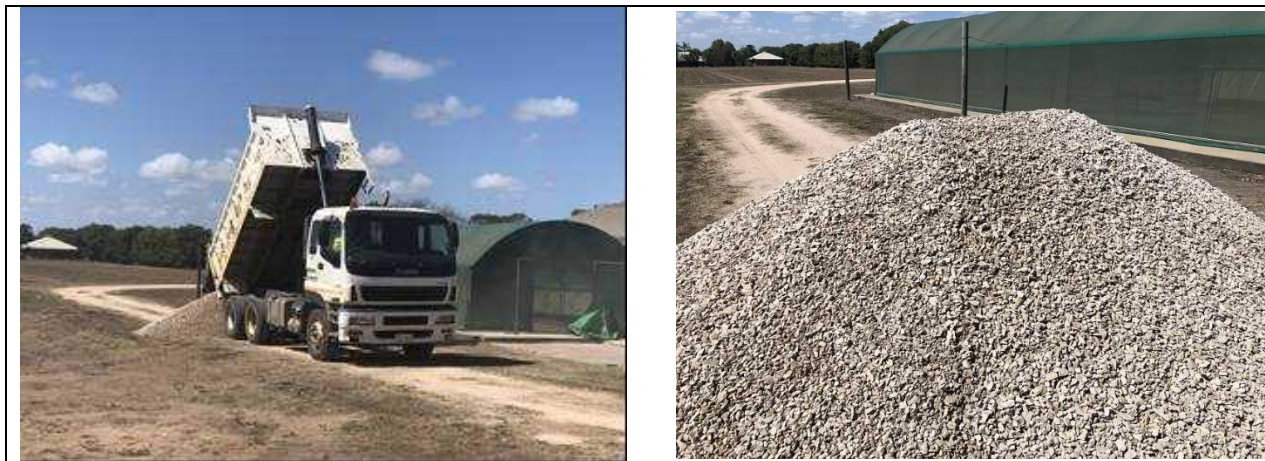
図表 31 購入した土等が搬入される様子
