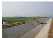
改修された水路
