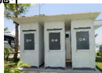
▲導入したパイオトイレ (2016年08月)
