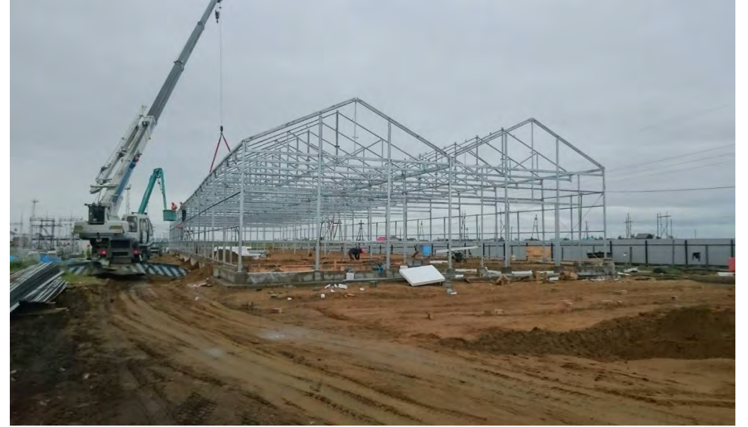
②鉄骨組み立て
