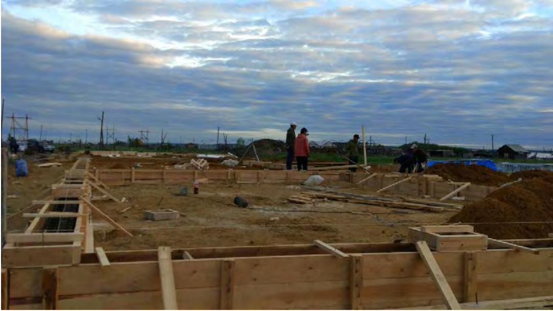
①着工・基礎工事
