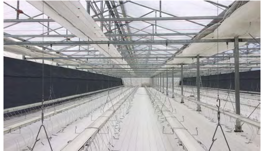
④設備工事
