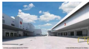
【海外の冷蔵・冷凍物流倉庫】
