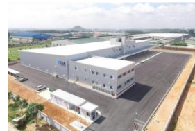
CLKコールドストレージ社の冷凍冷蔵倉庫(2016年完成)
