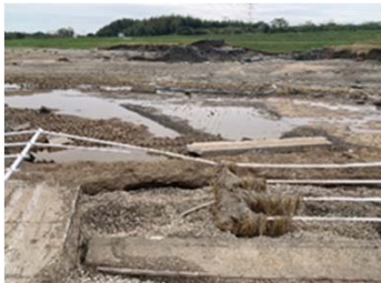
大規模な浸水被害を受けたほ場
