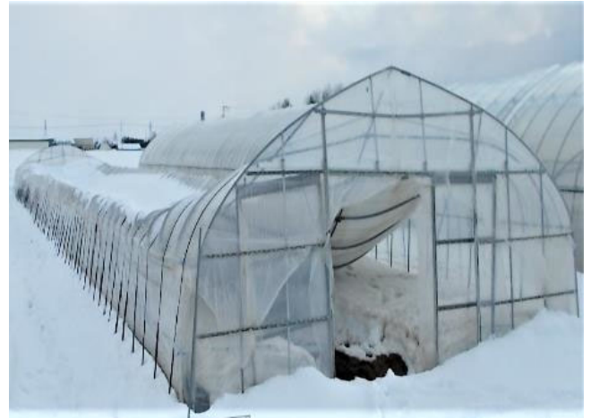
＜雪による被害の様子＞
