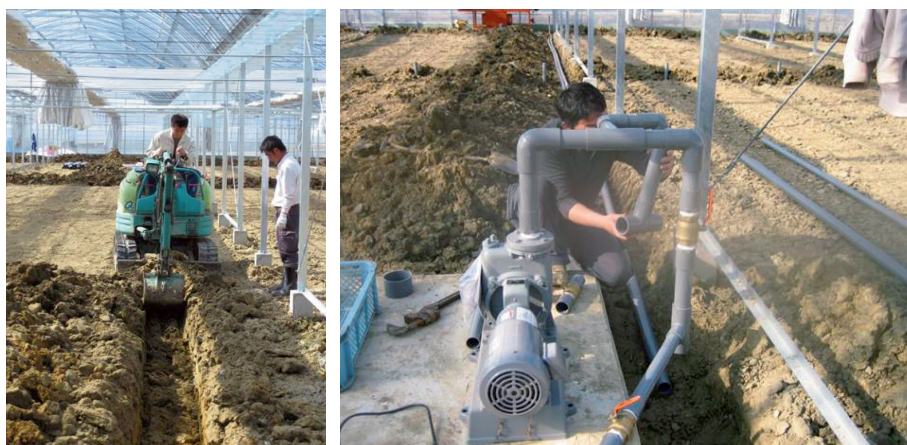
写真4 栽培システムの設計施工も内製化
