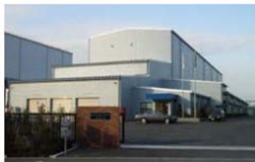
食品残さを堆肥化する堆肥場
