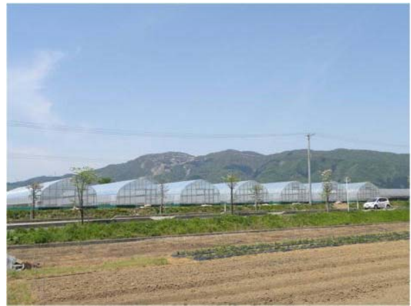
自社で設置したビニールハウス
