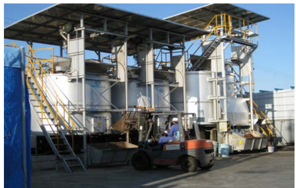
食品廃棄物を処理する施設
