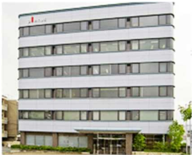
福岡オフィス (福岡県福岡市) →現在建て替え中
