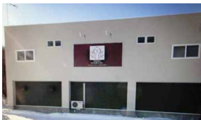
新築中のラボラトリー (令和2年10月から稼働する加工処理施設)
