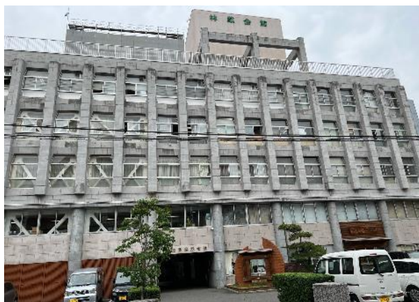
えひめ農業経営サポートセンター外観 (愛媛県林業会館)
