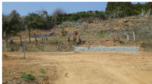
小規模基盤整備ほ場
