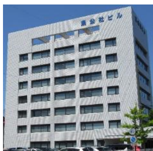
外観（新潟県公社総合ビル）
