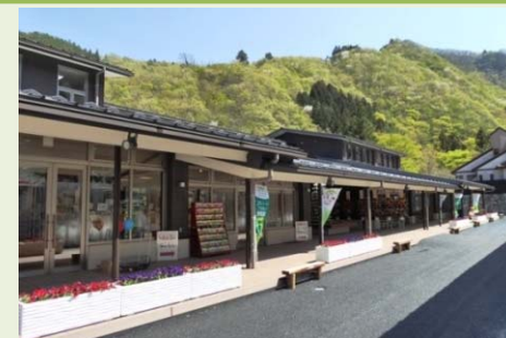
道の駅「上野」の一角に直売所等を整備
