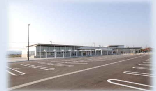
道の駅「めぐみ白山」内に 地産地消レストラン・直売施設を整備
