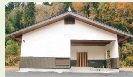
伝統技術継承施設
