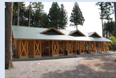
交流施設（バーベキューハウス）
