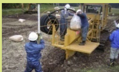
③ 暗渠排水
