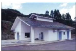
簡易給排水施設
