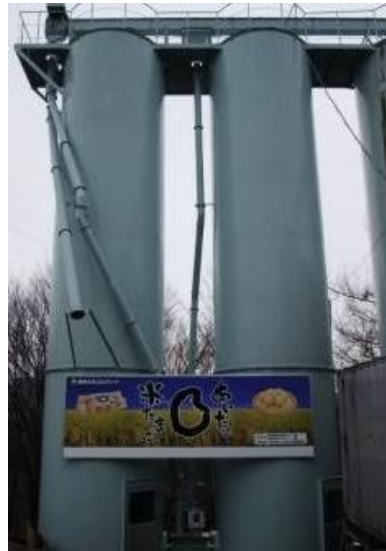
自家配合飼料工場にて専用 サイロからコンピューター制 御で自動配合
