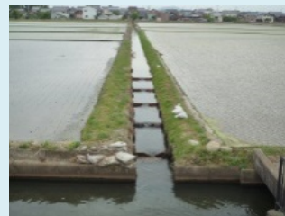
魚が遡上できる排水溝 (堰板を階段状に設置し、田んぼと同じ水位を保つ)
